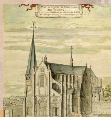
Le dernier étage de la tour est ouvert par des baies geminées qui laissent passer le son des cloches. Une flèche construite en 1487 couronnait le clocher. Elle s'effondra en 1710 à la suite d'une tempête.
